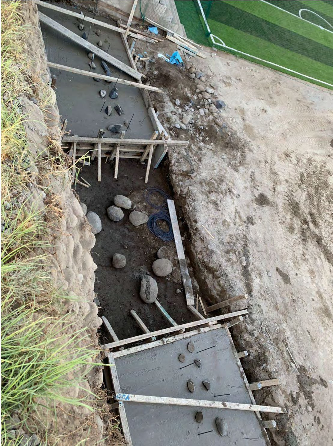
VACIADO DE CONCRETO – CIMIENTOS MURO DE CONTENCIÓN
