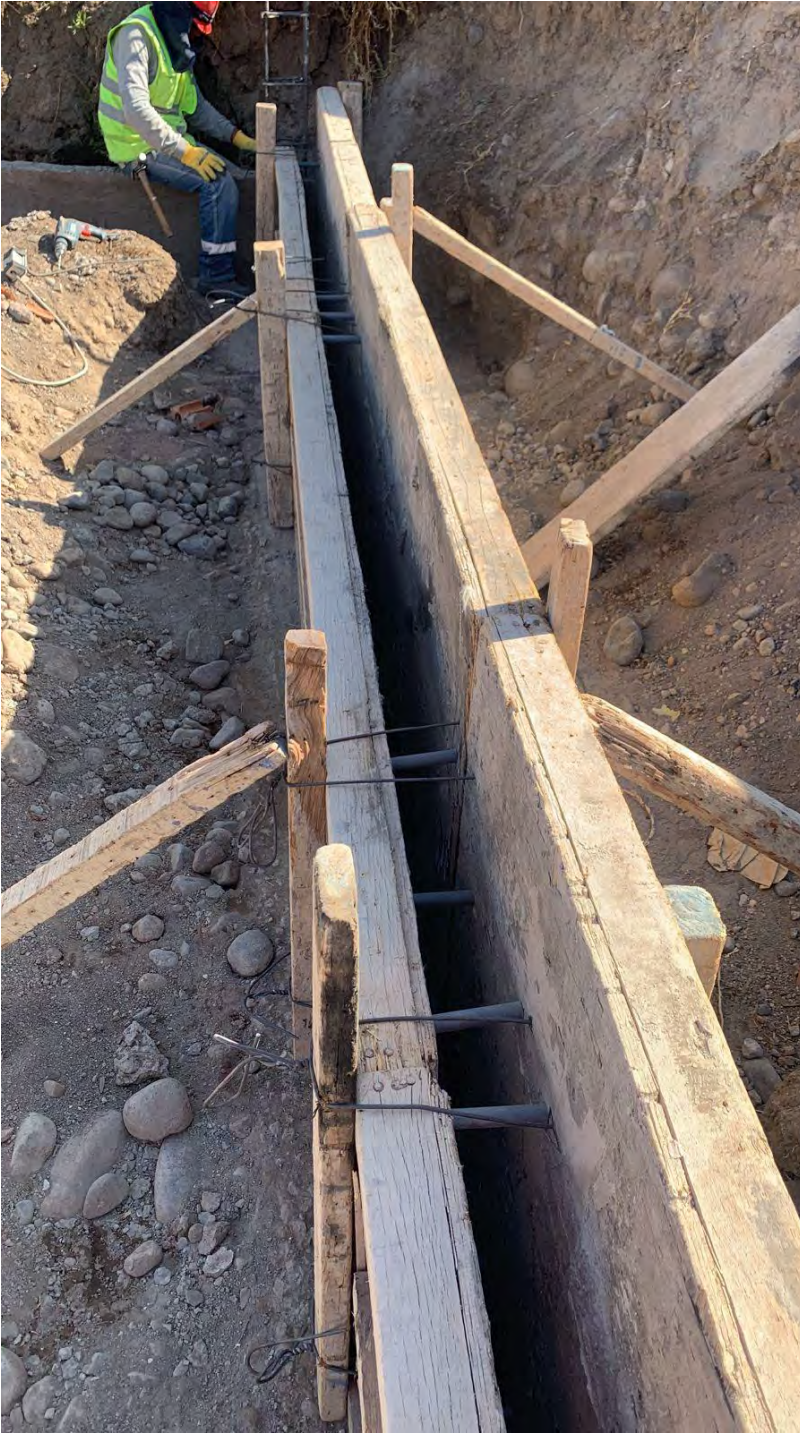
ARMADO – ENCOFRADO DE CIMENTOS – MURO PERIMETRICO
