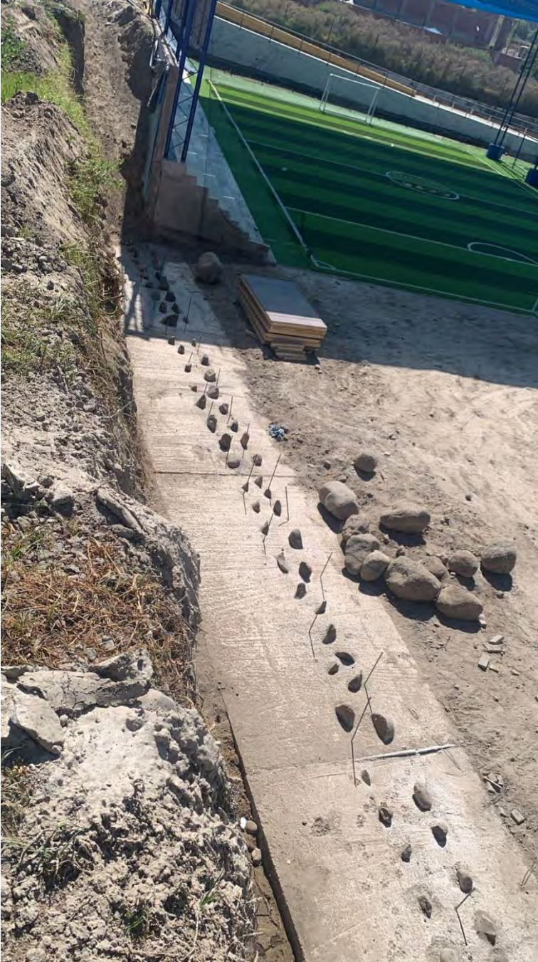
VACIADO DE CONCRETO – CIMIENTOS MURO DE CONTENCION
