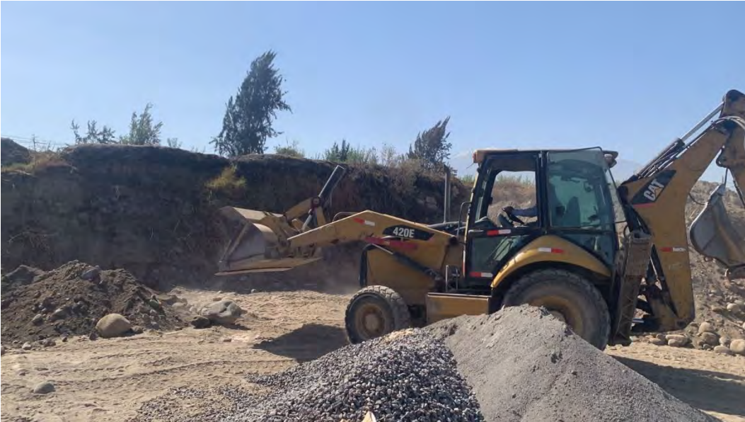
MOVIMIENTO DE TIERRAS – CARGUIO DE MATERIAL CON EQUIPOS
