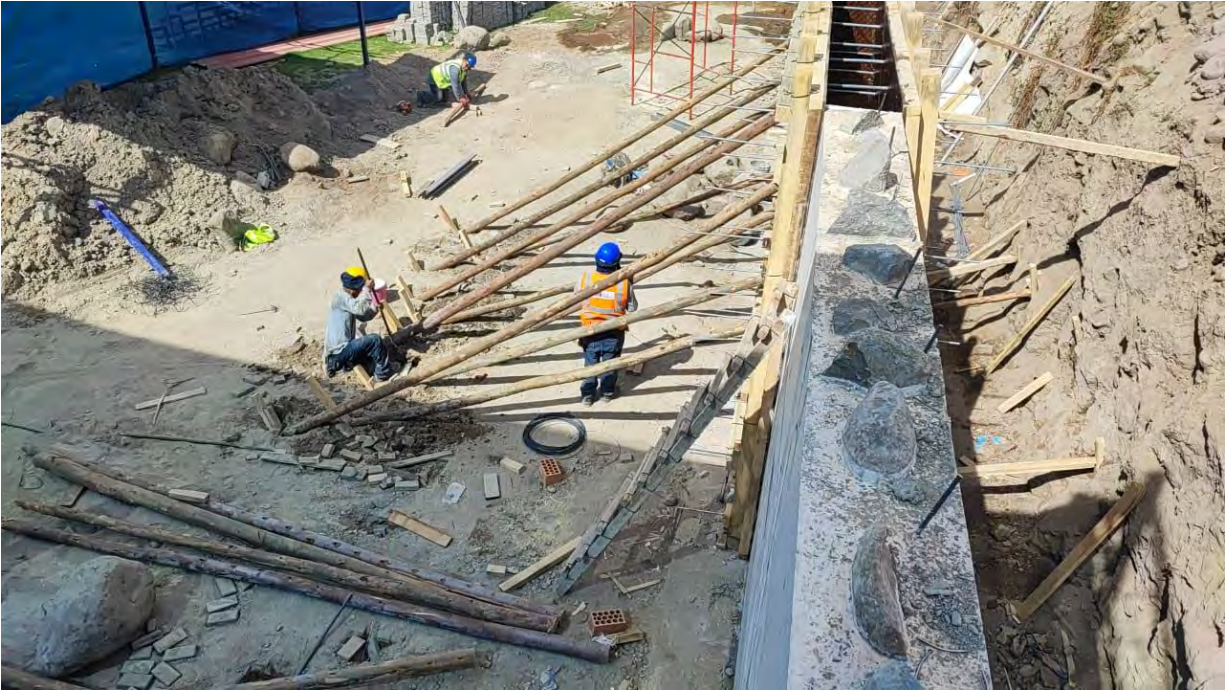
ARMADO DE MURO DE CONTENCION – ENCOFRADO
