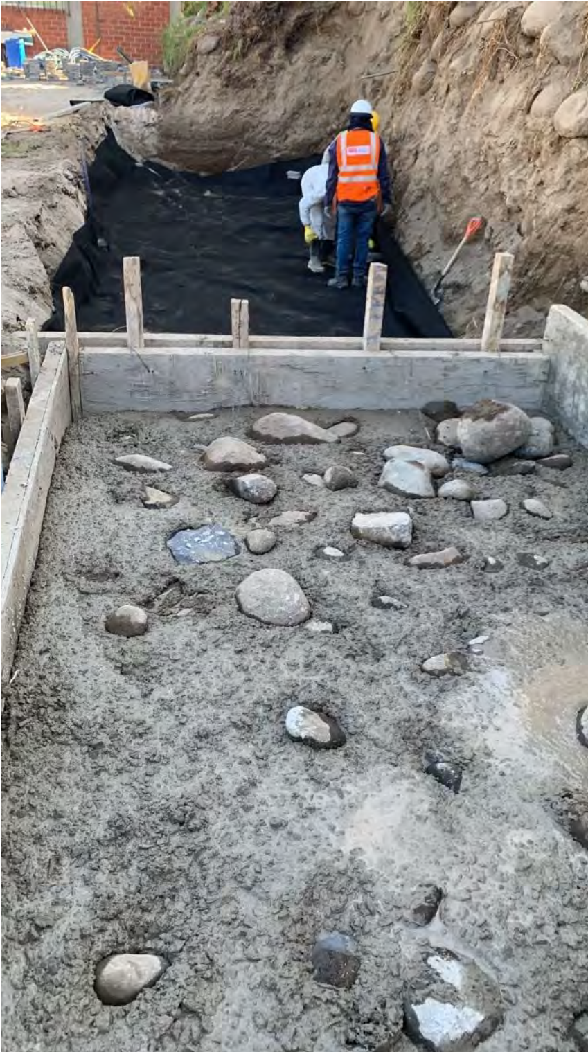
VACIADO DE CONCRETO – CIMIENTOS MURO DE CONTENCION
