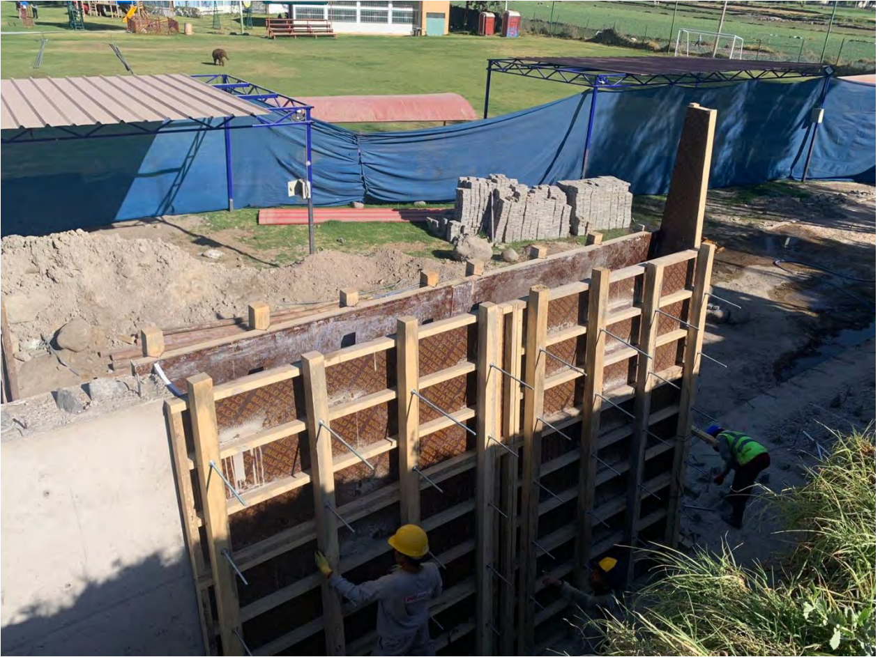
MURO DE CONTENCION 25 ML
