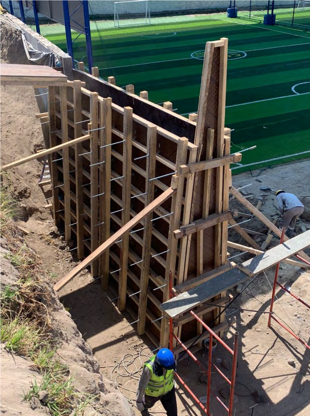
ARMADO – ENCOFRADO DE MURO DE CONTENCION – SEGÚN DISEÑO
