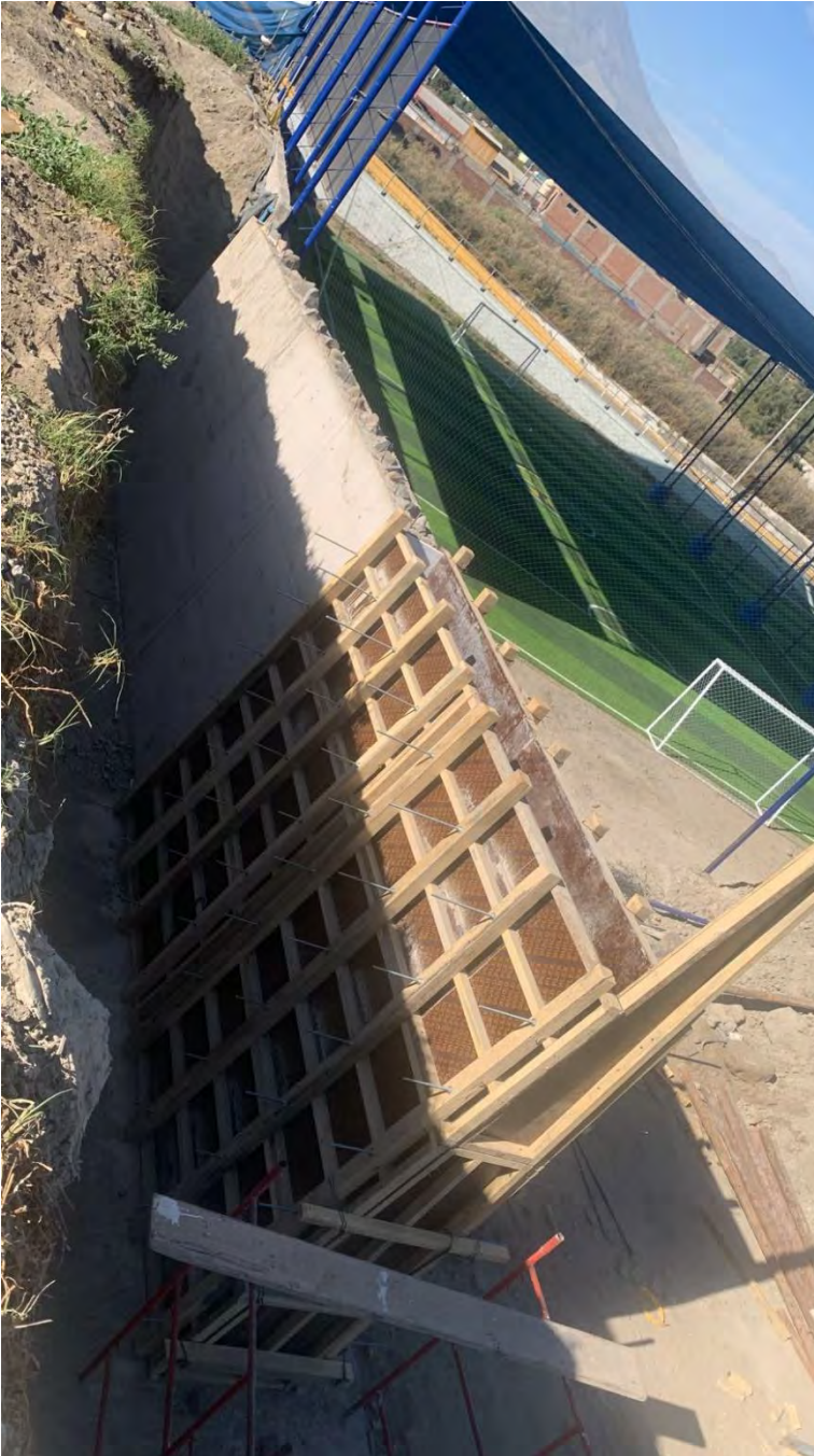
MURO DE CONTENCION 25 ML
