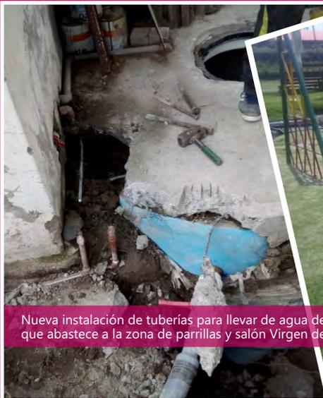
Nueva instalación de tuberías para llevar de agua de subsuelo al pozo que abastece a la zona de parrillas y salón Virgen de Chapi.
