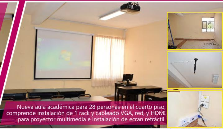
Nueva aula académica para 28 personas en el cuarto piso, comprende instalación de 1 rack y cableado VGA, red, y HDMI para proyector multimedia e instalación de écran retráctil.
