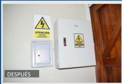
Uno de los trabajos para obtener la certificación de Defensa Civil fue la instalación de un nuevo tablero eléctrico general en el local institucional, centralizando las líneas trifásica y monofásica, con conexión a tierra que vienen de los diferentes niveles, cumpliendo con las normas establecidas para este tipo de instalaciones.
