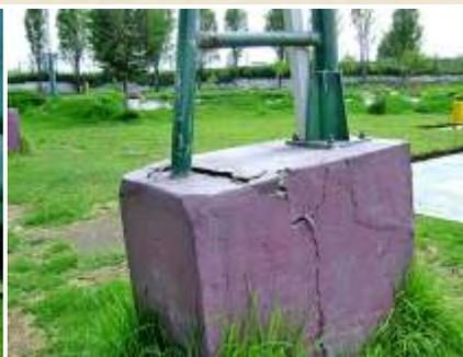
Ruptura de bases en columnas para mallas Raschel.
